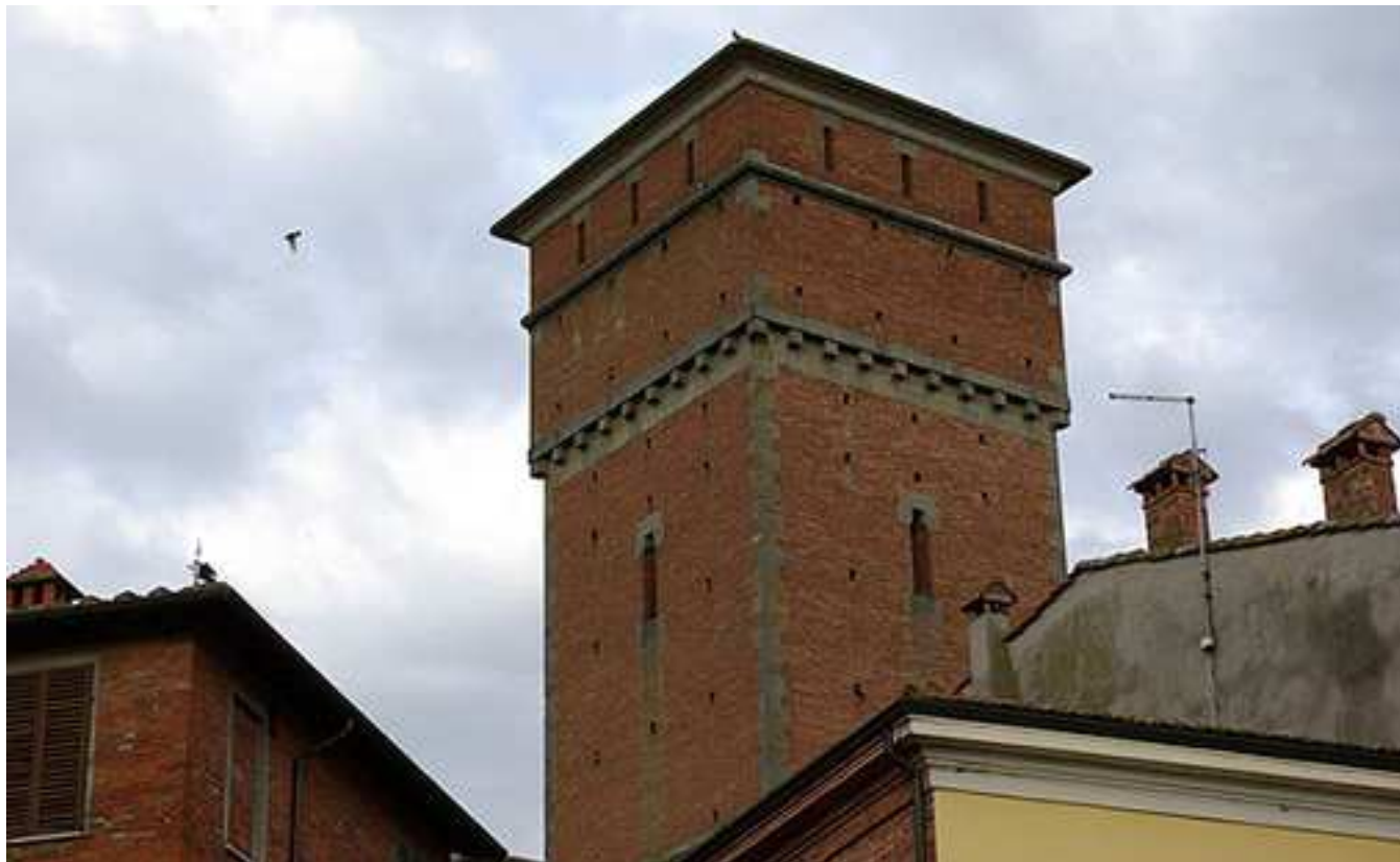
Foto: acquedotto di Bettolle
