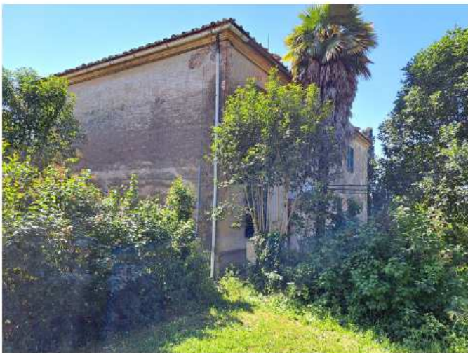
Prospetto lato posteriore
