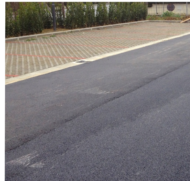
Asfalto e pavimentazione in elementi autobloccanti
