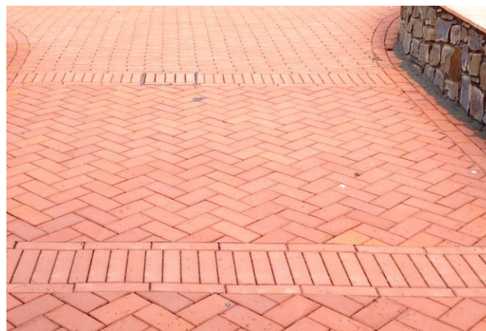
Marciapiede con elementi autobloccanti
